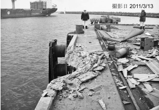
写真6 本船船先激突により棧橋破損 撮影日 2011/3/13
