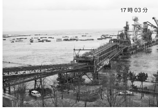
写真6 本船船先激突により棧橋破損 撮影日 2011/3/13
